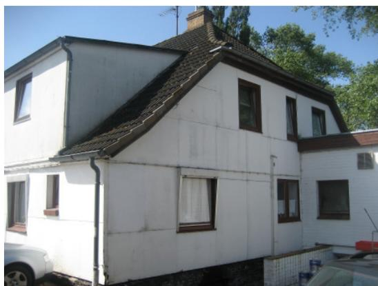
Bild 7, planasbestbekleideter rückwärtiger Gebäudegiebel
